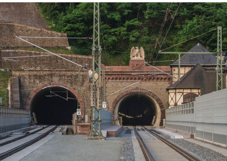
Der 4.205 m lange Kaiser-Wilhelm-Tunnel befindet sich zwischen den Bahnhöfen Ediger-Eller und Cochem - erbaut zwischen den Jahren 1874 bis 1877
