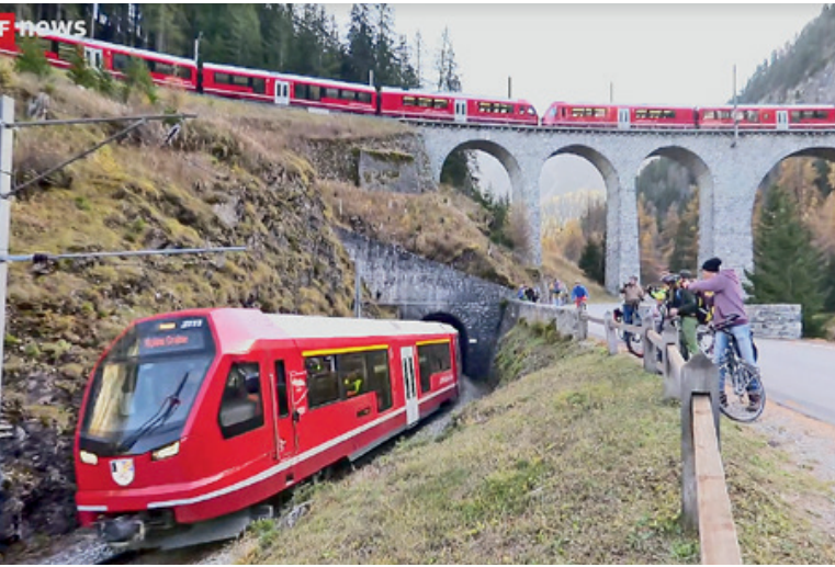
Nachdem bereits das 95 m lange Albulaviadukt II passiert wurde, eine Sicht auf das Albulaviadukt III (oben). Darunter die Ausfahrt der ersten „Capricorn“ Triebwagen Zugmaschine Nr.3111“ am Toua-Kehrtunnel. Foto: SRFnews.
