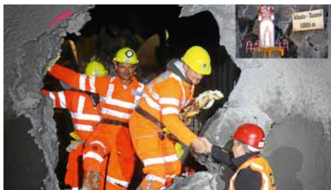
Mineure des südlichen Tunnelvortriebs überreichten nach erfolgtem Durchstich eine Statue der Bergarbeiter Schutzpatronin Heilige Barbara an ihre Kollegen der Nordseite. Die Statue wird wie bereits im alten Albulatunnel (oben rechts eingebildet) einen Ehrenplatz im Tunnel II bekommen.
