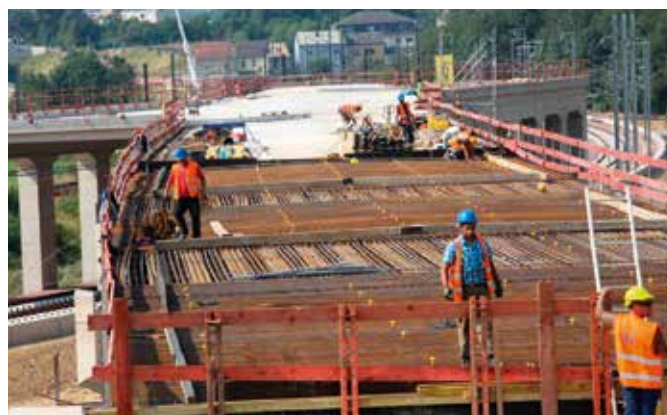
13.Juli 2018. Blick auf die Bewehrungsarbeiten der oberen Fahrbahnplatte des Saut de Mouton mit Armierungstäben aus Betonstahl.
