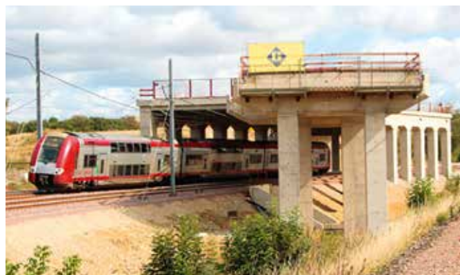
Einer der ersten Züge L-Bt kurz vor der Einfahrt Bettemburg am 25.8.2018, dem Tag der Inbetriebnahme der neuen Livingier Kurvenstrecke unter dem Saut de mouton. Rechts im Bild die stillgelegte und bereits teilweise abgebaute alte Bahnkurve. Foto Armand Schilling.
