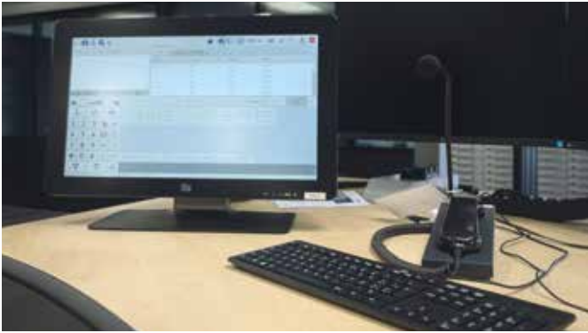
Bildschirme und Telefone für den neues digitalen Zugfunk (GSM-R) sind installiert. Bis zu dessen offiziellen Inbetriebnahme wird ....
