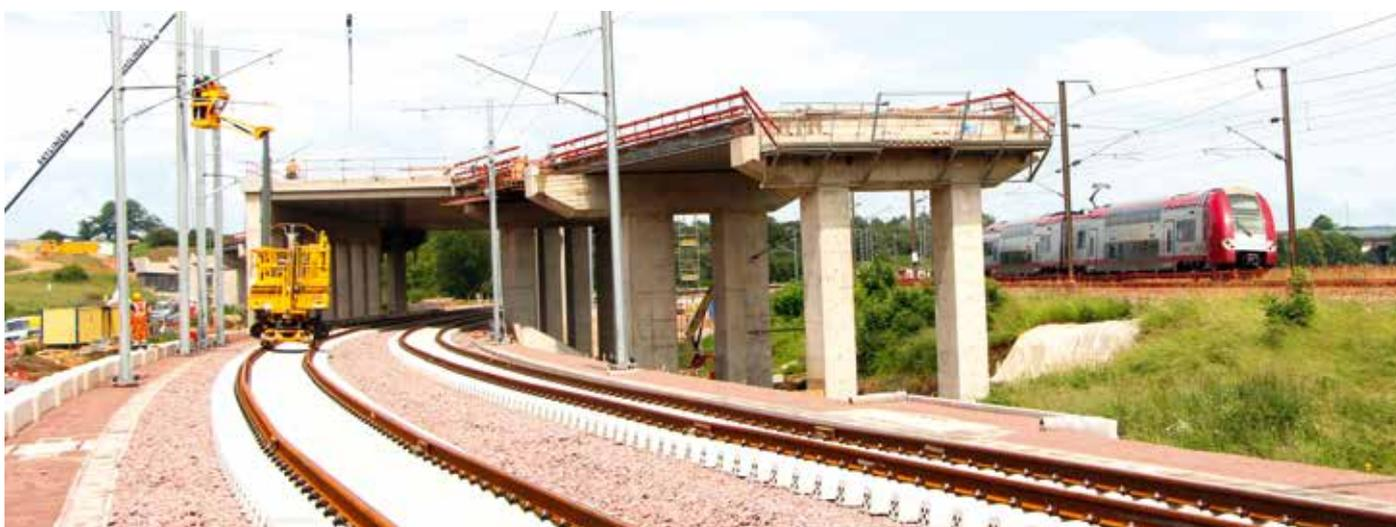
Am Ausgang des Bahnhofs Bettemburg zwischen den PK 6.0 bis PK 6.7. ist bereits das um etwa 30m seitwärts unter den „Saut de mouton“ versetzte Gleispaar auf der Gleisbettung verlegt. Derzeit (Zustand vom 7.6.2018) werden hier die Feederleitungen auf die Fahrleitungsmasten montiert. Foto: A. Schilling
