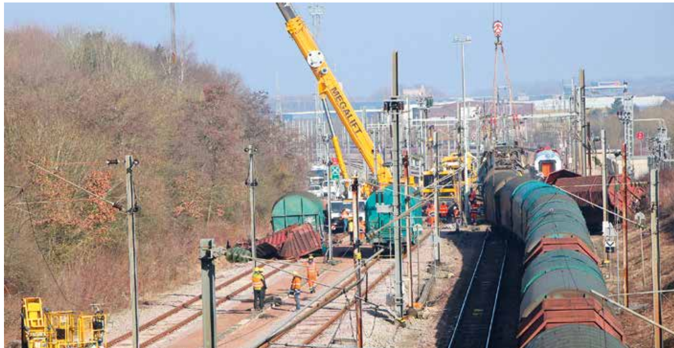
Zunächst mussten die leeren Güterwagen mit einem 90t schweren (Tragkraft bis 300 t) Spezialkran von der nach dem Rangierbahnhof weisenden Gleisung entfernt und auf ein Nebengleis gesetzt werden.
