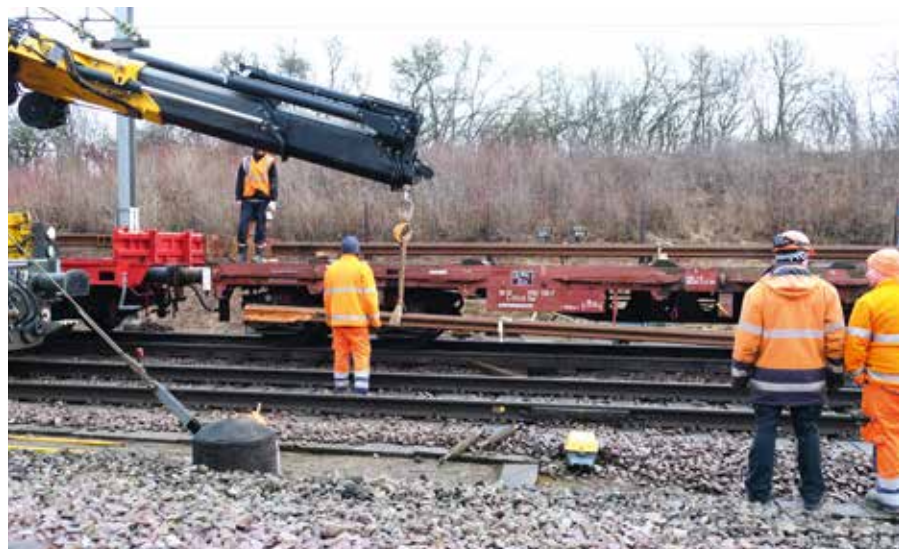
Arbeiten an den Gleisen: Schienen werden ersetzt
