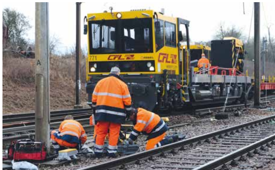
Arbeiten an der Signaltechnik
